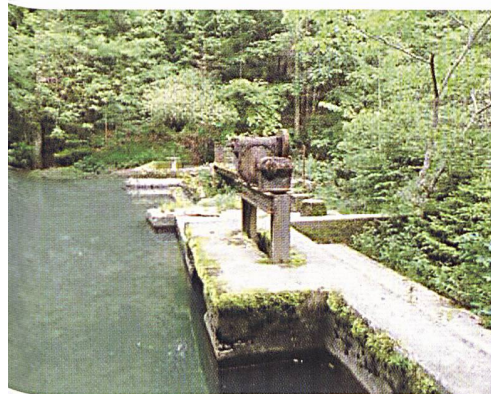
Barrage vu depuis la berge.
