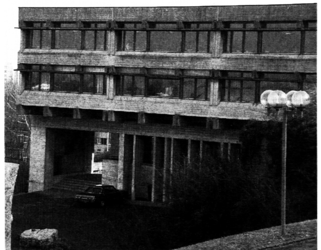
Schulhaus Stettbach in Schwamendingen – ein nicht unfreundlicher Betonklotz ...
