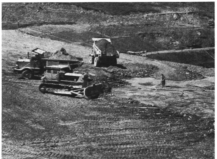
Bild eines Bulldozers oder Planierpfluges im Dammgelände.
