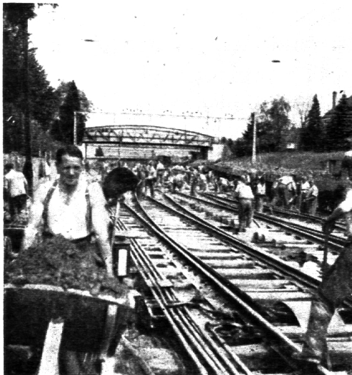
Absenkung des Westkopfes in Wylerfeld bei einem Verkehr von rund täglich 220 Zügen. (Nr. 4068. B R B 3. 10. 39. Fotodienst S B B.)
