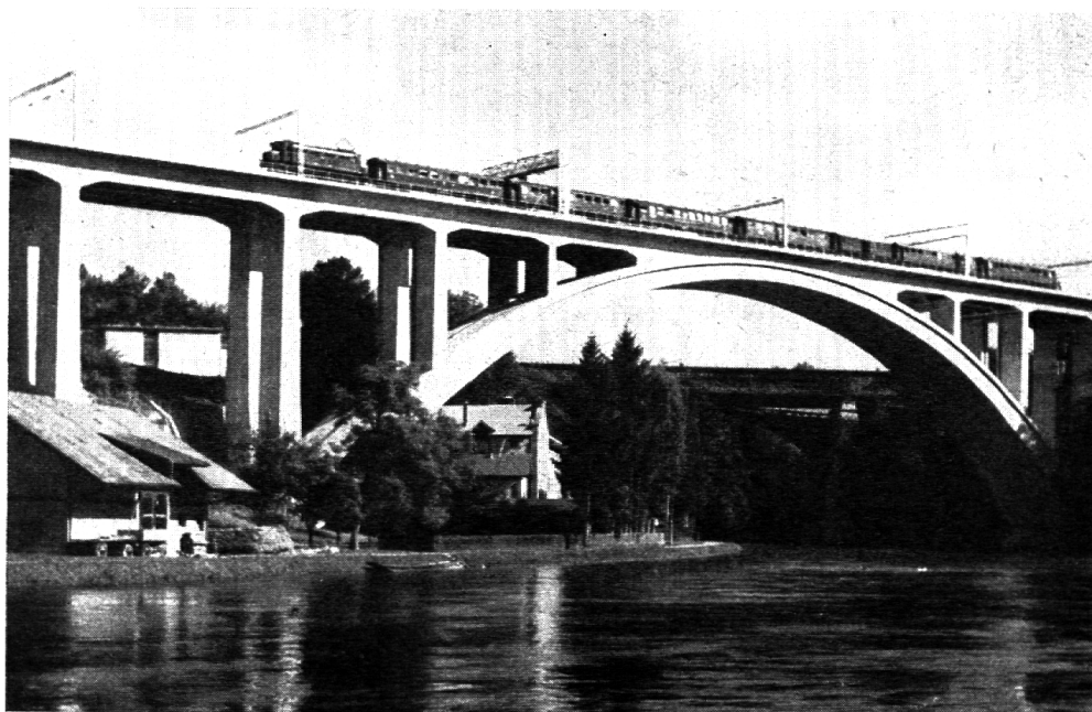
Los 4: Blick auf das grosse Gewölbe aareaufwärts mit der alten Bahnbrücke im Hintergrund.
