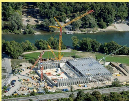
01 Luftaufnahme Ausbildungszentrum Mülimatt: Eine Dreifachturnhalle ist bereits gedeckt, bei der anderen ist die Tribüne sichtbar (Foto: Element AG)
