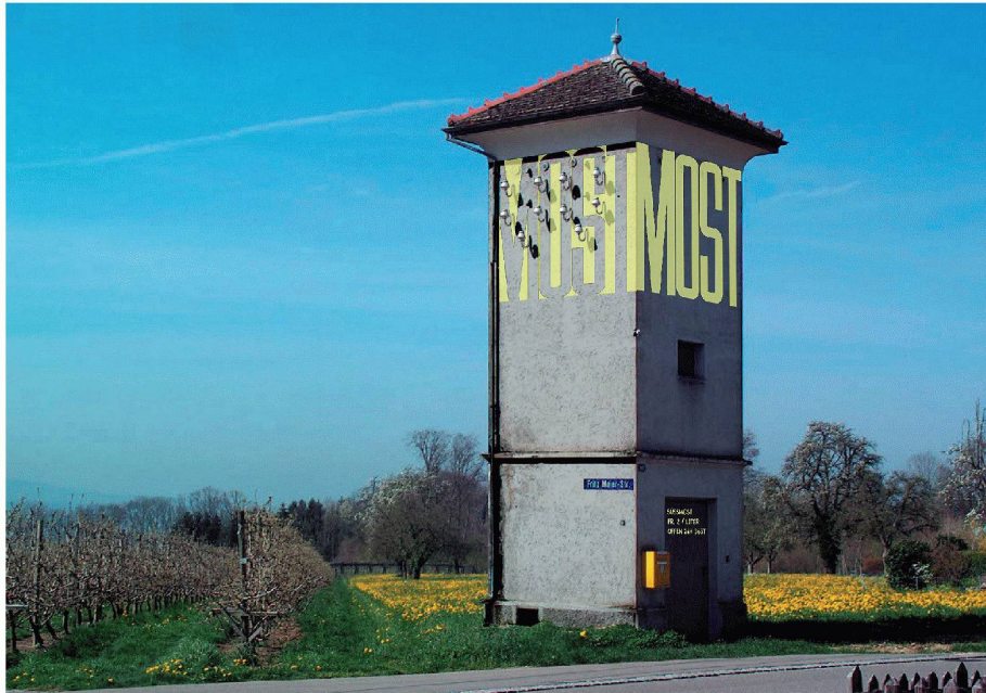
01 Obstanbau und Ausschank – das Projekt «Most Wanted» verwandelt die Trafostation ohne Umbauten in einen Mostturm (Mayo Bucher mit Drexler Guinand Jauslin Architekten, Zürich)
