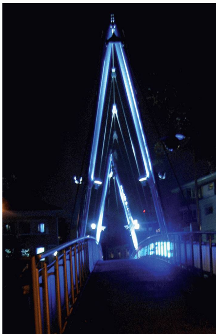
02 Fussgängerbrücke von STEAG (2000) im nächtlichen Lichtgewand (Bilder: Autor)
