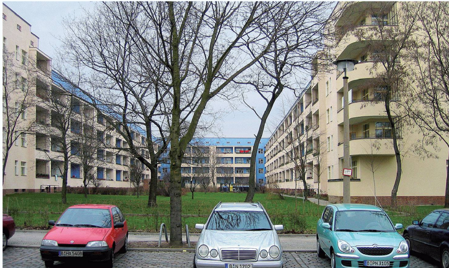
01 Wer wohnt im Weltkulturerbe? In der renovierten Wohnstadt Carl Legien (Bruno Taut 1928–30) hat der Bezirk Berlin Pankow für Mieterschutz gesorgt (Bild: Autor)
