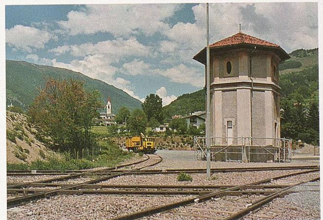
Kuriosum aus dem Dampflok-Zeitalter: Der statt einer Drehscheibe errichtete Wendestern um einen Wasserturm in Mals. Fünf Mal mussten die Dampfloks zum Wenden die Richtung wechseln, bis sie wieder vor die talabwärts fahrenden Züge gekuppelt werden konnten
