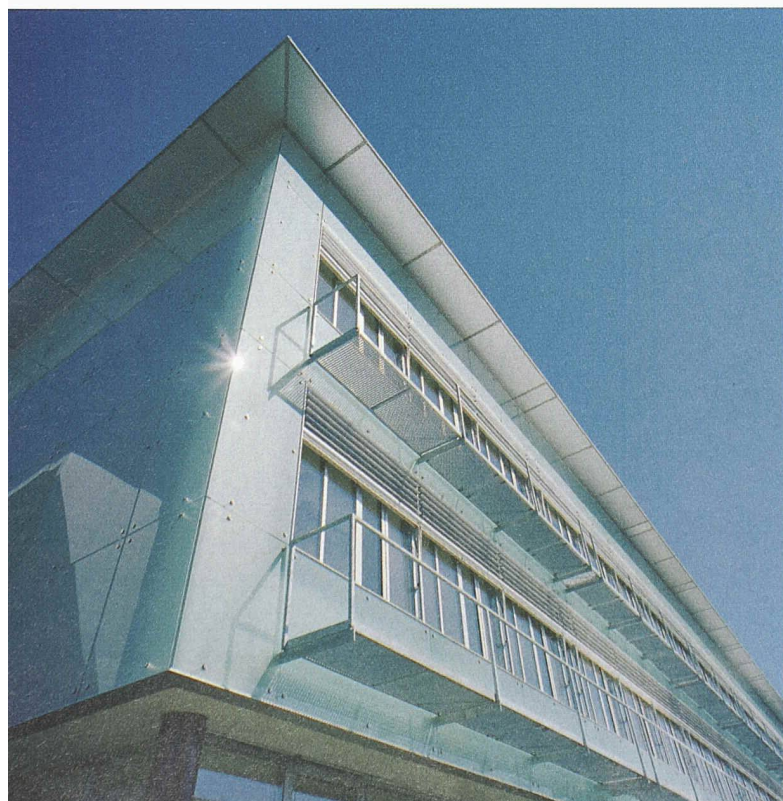
Neu: Glasfassade, Vordach und Reinigungsbalkons (Bild: Markus Beyeler)
