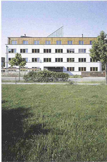
2 Haus Focus: Ansicht von Nordosten
