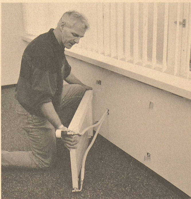
Die Heizkörper sind im Betriebszustand abhänger
