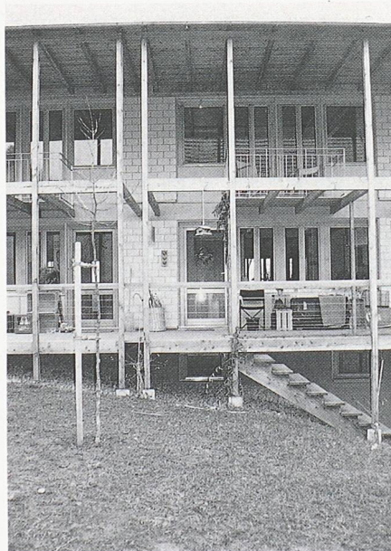
Bild 6. Die Holzkonstruktion (Lärchenholz) der Laubengangszone ist exakt auf dem gewachsenen Boden abgestützt (Bilder 3, 4, 5 und 6: Marc Meyer, Gabriela Weber Meyer)
