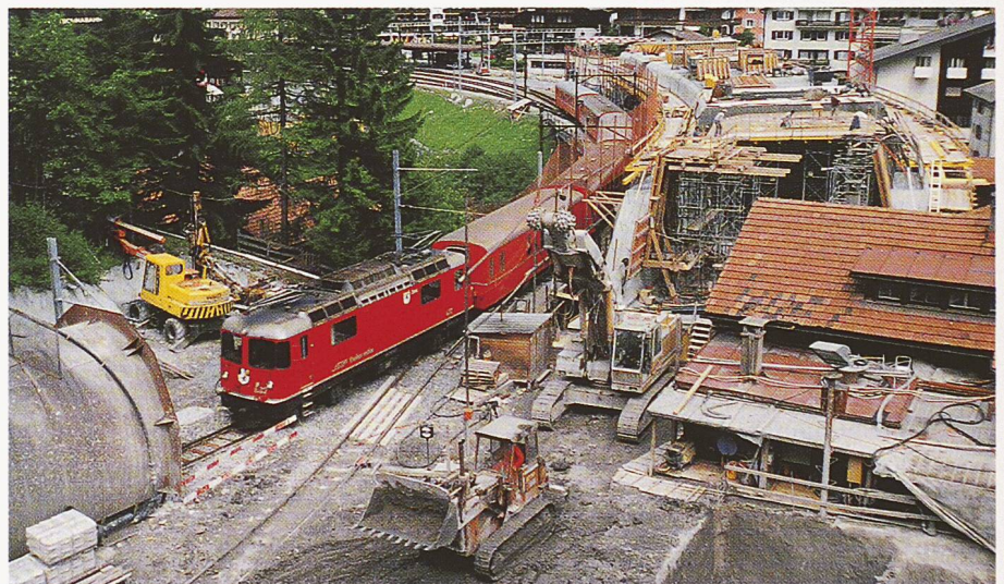
Bild 6. In der 1. Bauphase verkehren die Züge über die alte Landquartbrücke. Die Baustelle Zugwaldtunnel wird über ein Stumpengleis beliefert
