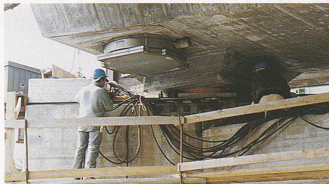
Die Brücke wird auf speziellen Verschublageren bewegt. An der Trogplatte untergehängt ist der obere Teil des definitiven Lagers
