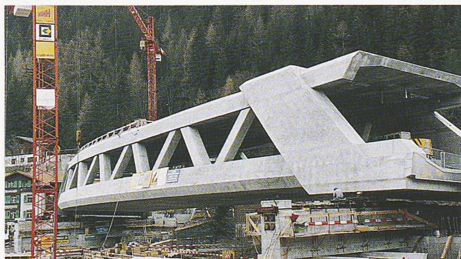
Die Brücke ist bereits 5 Meter verschoben. Provisorische Bauwerke für die Verschubbahn.
