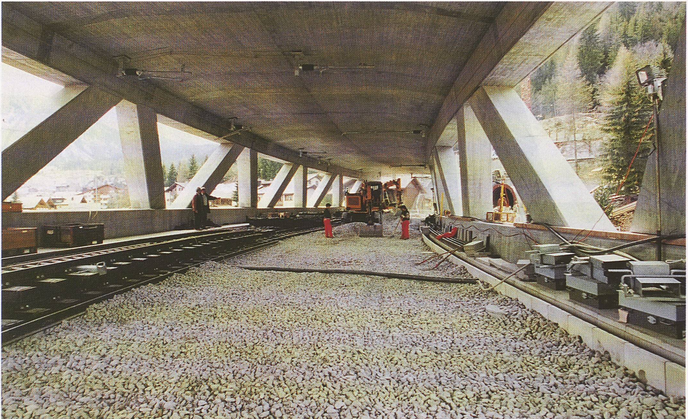
Während der Bahneinstellung werden die definitiven Gleise – rechts Richtung Davos, links Richtung Selfranga-Vereina – verlegt
