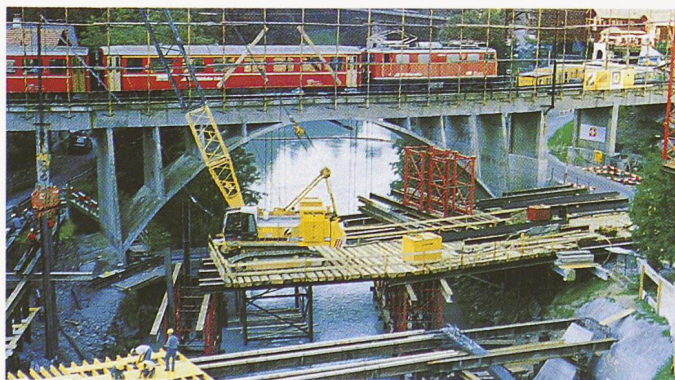
Blick auf die alte Bogenbrücke mit Zugeinfahrt in den Bahnhof Klosters, auf Dienstbrücke/Lehrgerüst und auf die Fussgängerbrücke im Bau (August 91)
