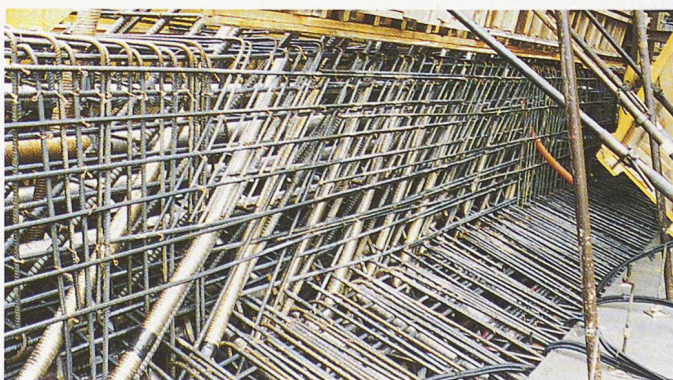
Randträger an Trogplatte; Details von Armierung/Vorspannung
