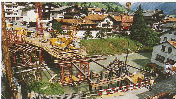
Rammarbeiten für Dienstbrücke/Lehrgerüst (August 91)
