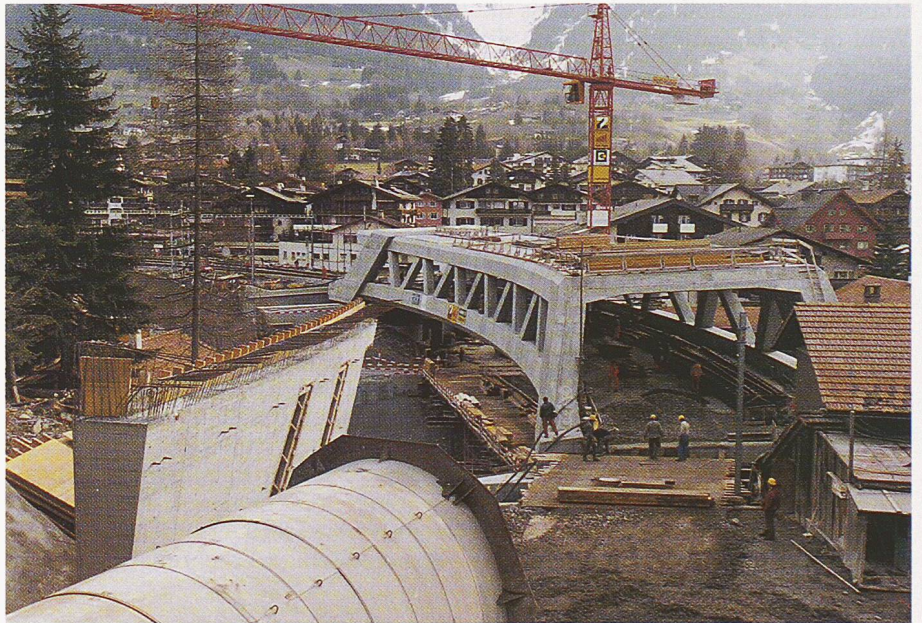
Das provisorische Gleis ist ausgebaut. Vorbereitungsarbeiten für Vershub
