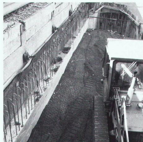
Filter- und Sickerschicht, keine Baugrubenverfüllung!
