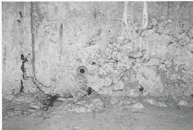
Bild 2. Kiesnester und rostende Bügel im Hohlkasten. Foto Aegerter & Bosshardt AG
