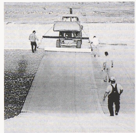
Verlegen einer Bentomat-Bahn
