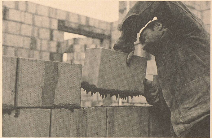
Der neue Tauchmörtel Lamitmur tuffa erlaubt eine rationelle Mauerwerkserrichtung
