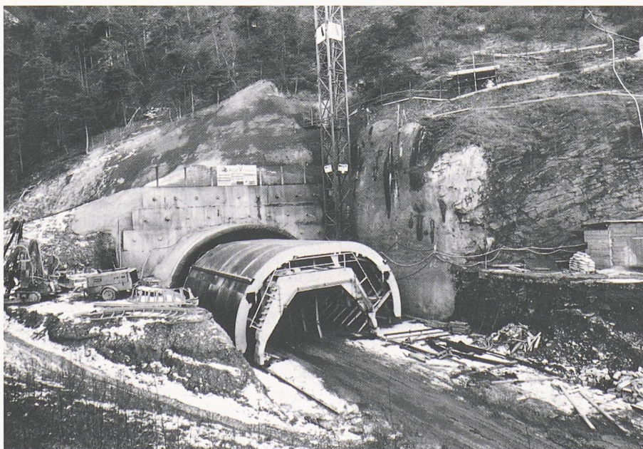
Bauarbeiten am Nordportal des Visper Umfahrungstunnels (Bild: Comet)
