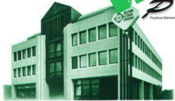
Geschäftshaus Adlikerkreuz, Regensdorf, Rötlich eingefärbte, sandgestrahlte Sandwich-Fassaden.
