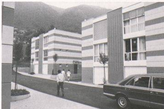
Bild 2. Einfamilienhaussiedlung im Tessin in Grosstafelbauweise von SAIE SA, Contone
