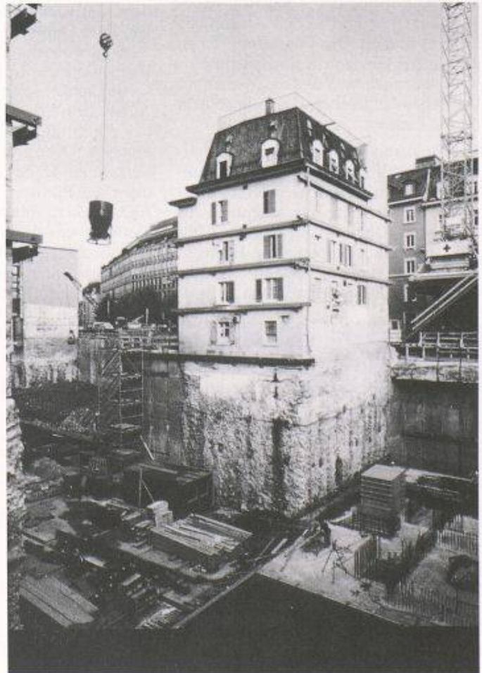
Bild 7. Unterfangung eines Bauwerkes am Stauffacher (Zürich) mit dem Soilcrete-Verfahren
