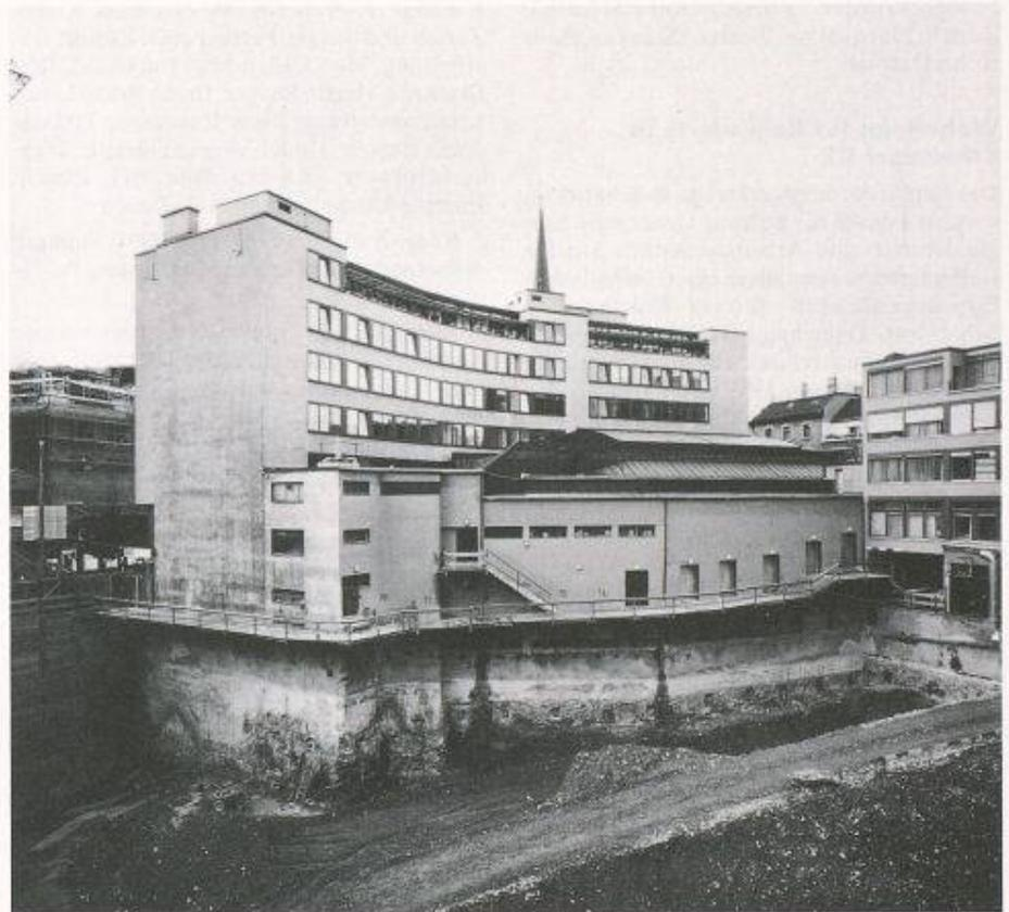
Bild 8. Bereich PAX-Gebäude: Freilegen der Soilcreteunterfangung
