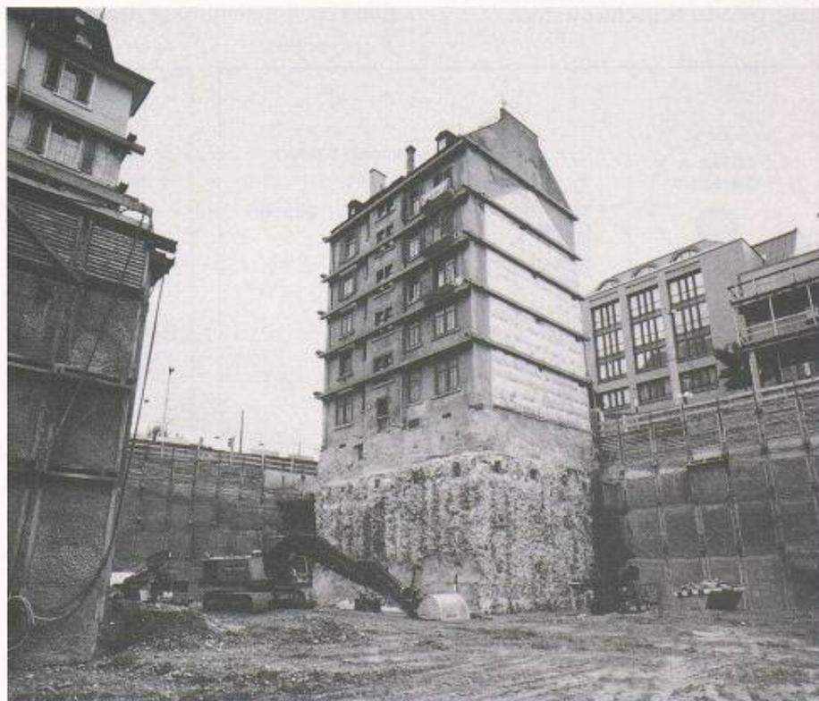
Bild 1. Fassadensicherung/Soilcreteunterfangung Badenerstr. 4, Endaushubphase
