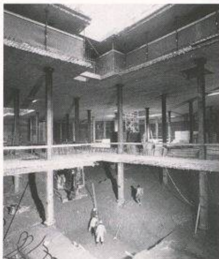
Bild 4. Die Untergeschosse werden in Deckelbauweise erstellt
