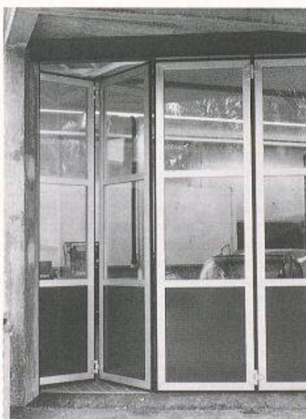
*Alu-Faltdorfront einer Servicegarage: Unterhaltsarme Bauweise, rasches Öffnen, gute Wärmedämmung, lange Lebensdauer*
