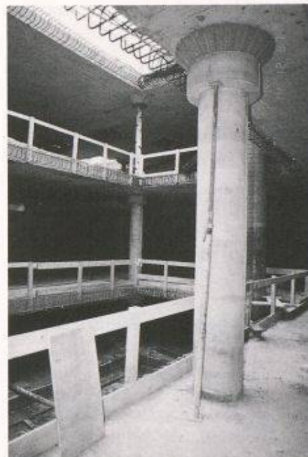
Bild 6. Der fertige Rohbau der Untergeschosse
