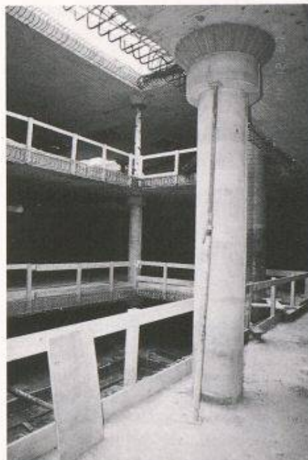
Bild 6. Der fertige Rohbau der Untergeschosse
