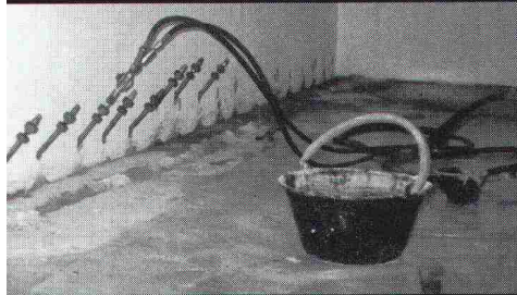
Elastische Abdichtungs-Injektion-Rascotex in einer Zivilschutzanlage.
