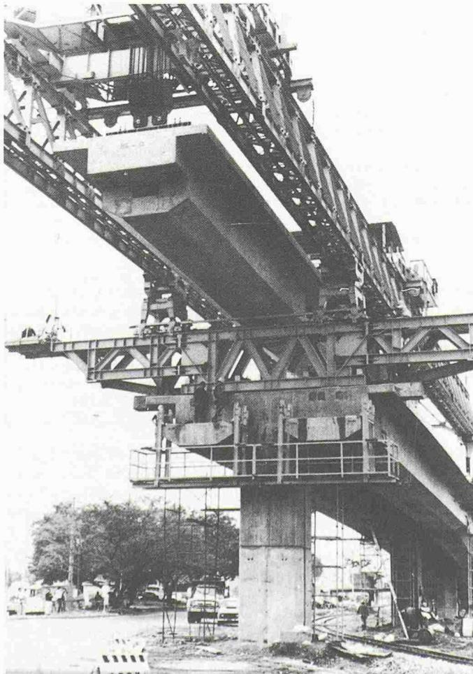
Bild 5. Metro Medellin in Kolumbien: Einbau eines 30 m langen und 230 t schweren Spannbeton-Fahrbahnträgers mit Verlegerät (Schambeck)
