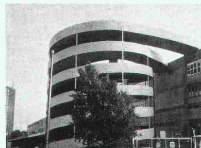
Rampe Parkhaus Migros Herdern
