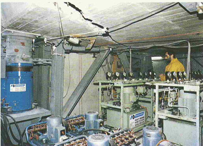
Bild 9. Hydraulikaggregate und horizontale Pressenfixierung (L. Buscarlet)
