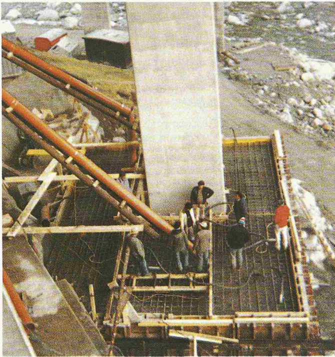
Bild 6. Betonieren neues Fundament R. Kalbermatten
