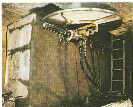
Bild 13. Bohr- und Fräsarbeiten am Pfeilerfuss für den Einbau des Gleitlagers Bildautor: A. von Glutz
