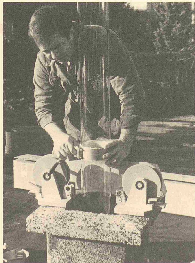
Einbau des Recusist-Kamin-Innenrohres
