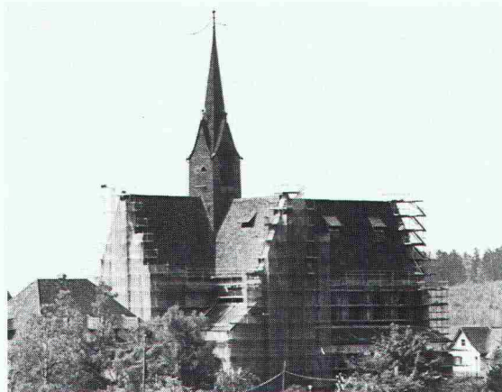
San Gian Celerina: statische Verbesserung der Turmdecke und Abdichtung gegen eindringen- des Wasser.
