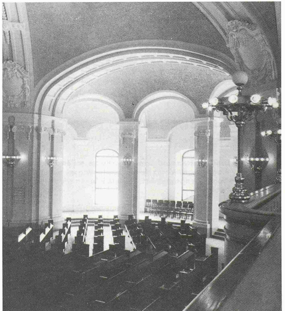
Blick in den Kirchenraum der Oberkirche
