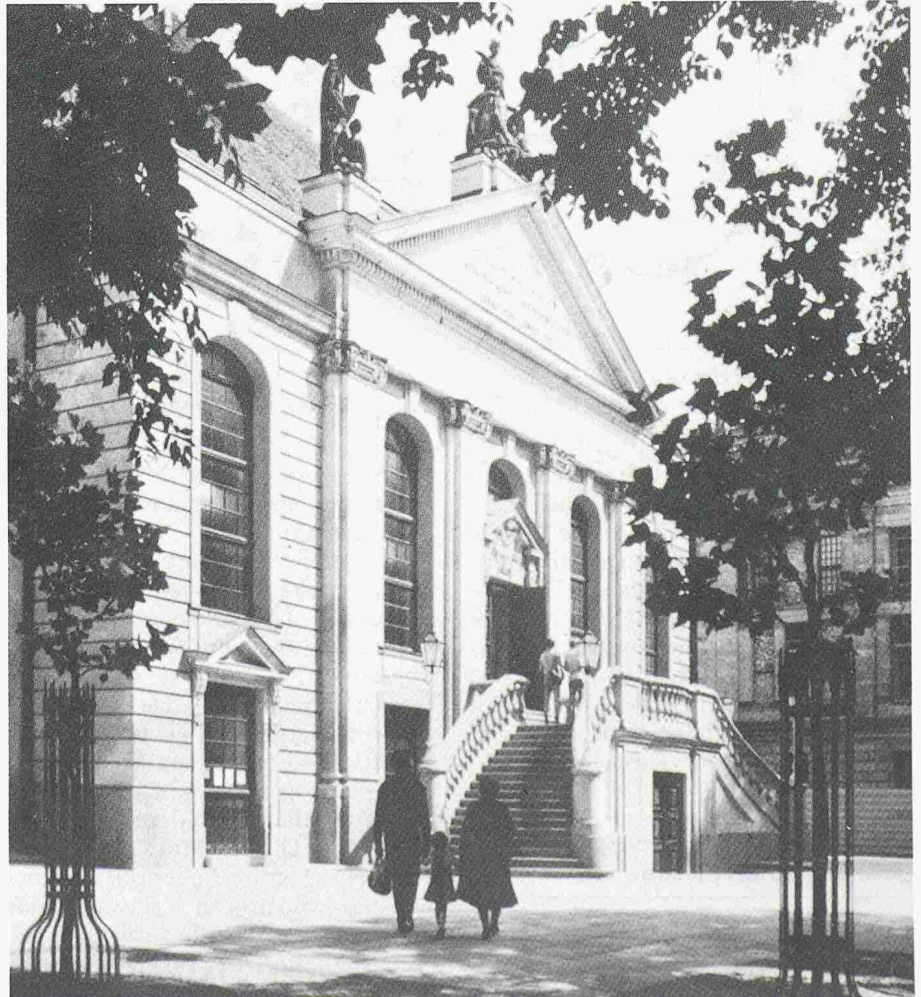
Haupteingangsseite zur Ober- und Unterkirche mit neuer Treppenanlage
