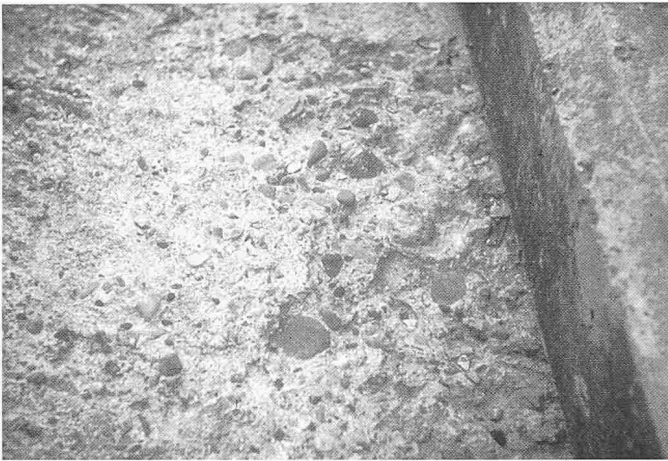
Bild 1. Typischer Frost/Tausalz-Schaden einer stark befahrenen Betonfahrbahn (Werkphoto SIKA AG)
