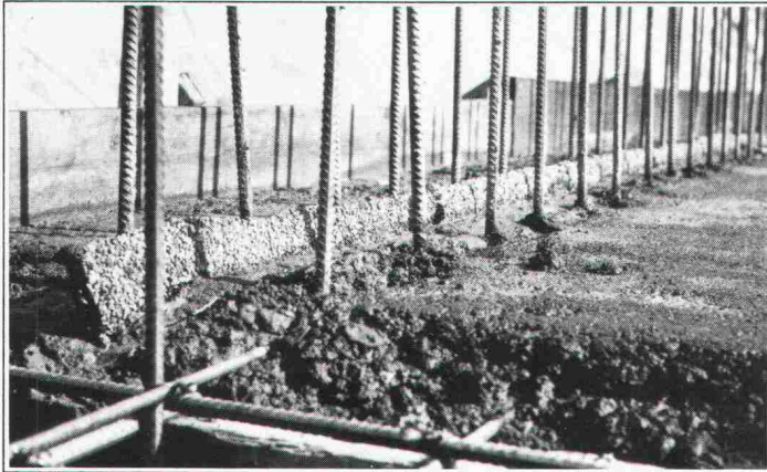
Erstellen einer Anschluss-Dichtung "BFL-MASTIX" Typ 20/70 R4.
