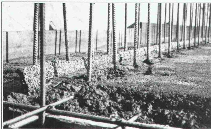
Erstellen einer Anschluss-Dichtung "BFL-MASTIX"
