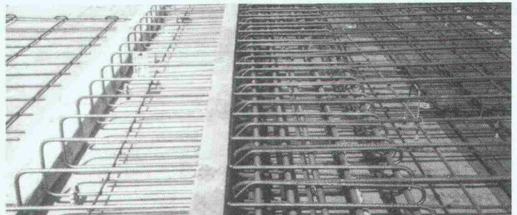
**ebea**® Kragplattenanschlüsse aus Ripinox erhöhen die Sicherheit
