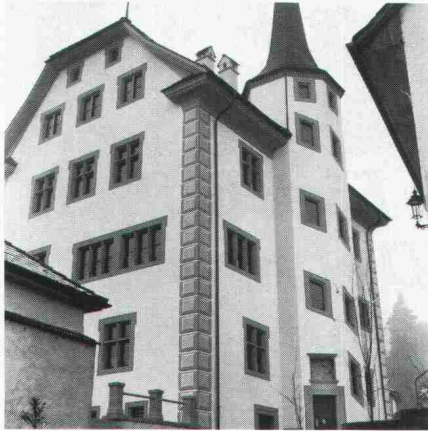
... wo historische Bauten gefährdet sind
