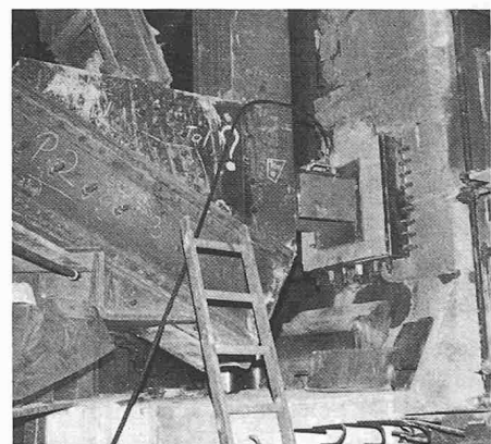
Bild 9. Gleitschuh der alten Brücke für den Ausschliebevorgang
