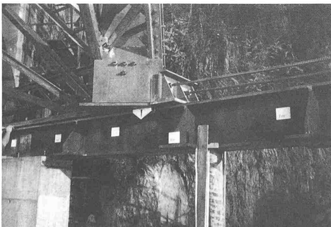
Bild 12a. Zugvorrichtung der alten Brücke
