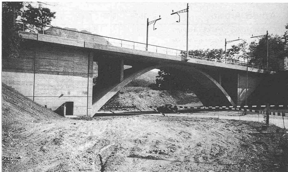
Bild 8. Ansicht der neuen Tassino-Brücke
