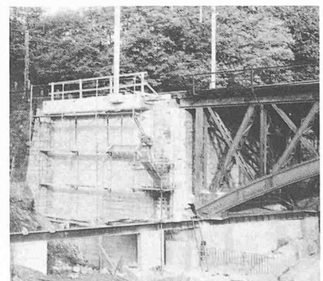
Bild 3. Verschubbahnen der neuen und alten Brücke
