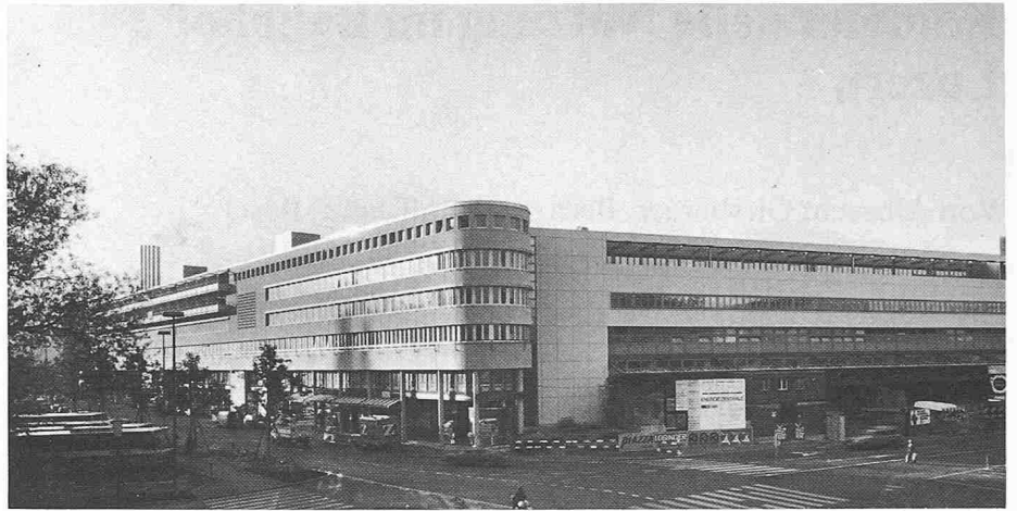
Bild 2. Ansicht Wohn- und Geschäftshaus Inseliquai (links) und Postbetriebsgebäude
