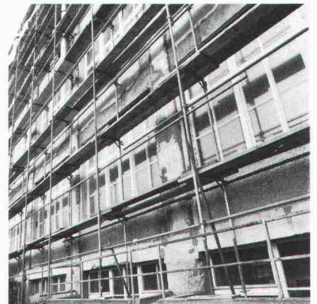
... wo Beton durch Umwelteinflüsse gefährdet ist
