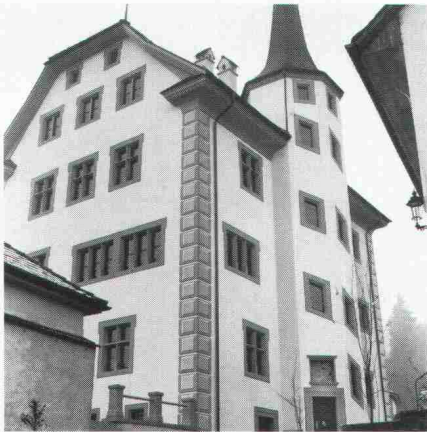
... wo historische Bauten gefährdet sind
