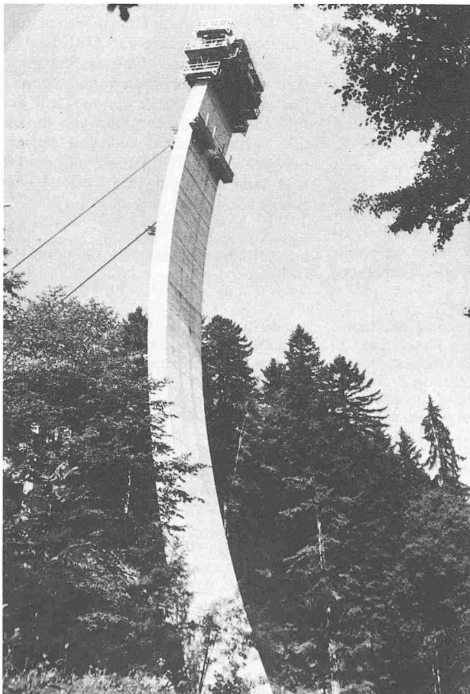
Bild 1. Die mit einer Kletterschalung erstellte lotrechte Bogenhälfte wird von Spannkabeln gehalten.
