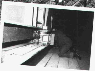
**Die auf der Verschiebebahn in 2 Reihen angeordneten NELL-Gleitlager sorgten für den geringen Reibungswiderstand.**
