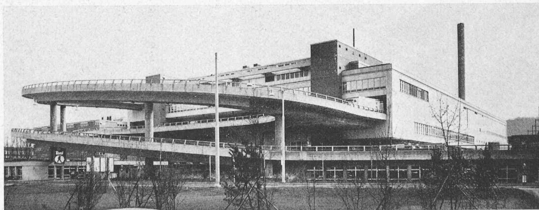
Ansicht des Rampenbauwerkes von Norden
