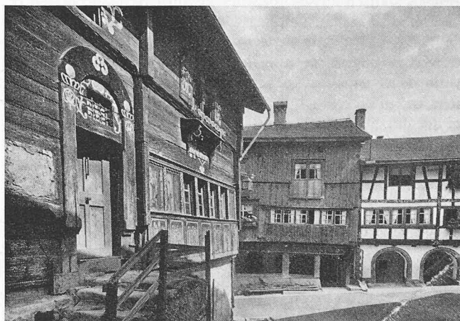
Werdenberg SG . Teilansicht des alten Markt- und Burgstädtchens. Links das «Rote Haus», ein Strickbau aus dem 17. Jh. mit Tätschdach und rustikal-barocker Fassadenbemalung. Im Hintergrund Frontalansicht zweier Bauten aus dem Hauptstrassenzug mit seinem durchgehenden Laubengang. Die älteste vorwiegend aus Holzbauten bestehende geschlossene Siedlung von 32 Firsten (erwähnt 1289) wird seit 1960 systematisch saniert und restauriert. Bauleitung: Architekt Walter Fierz , St. Gallen Photo J. Gaberell , Thalwil
