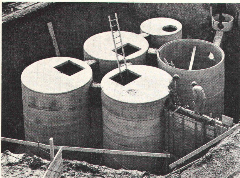
Einbau einer biologischen Kläranlage im Kanton Schaffhausen
