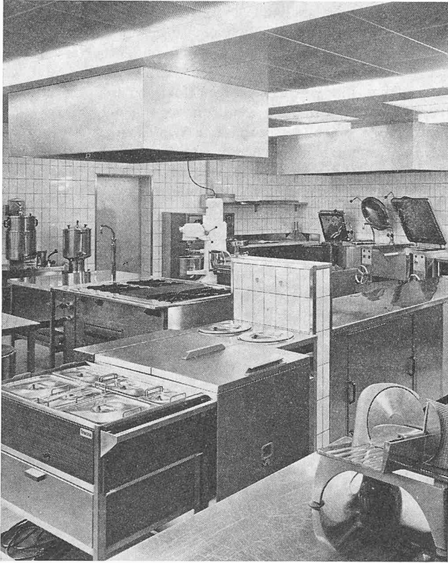
Küchenanlage. Vorn Service-Gang
