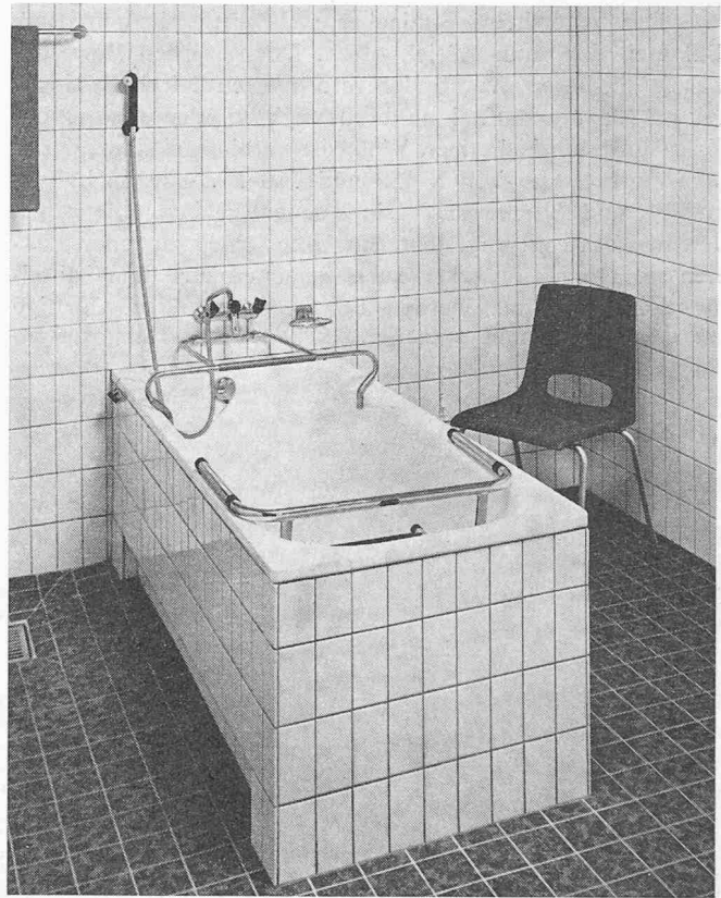
Wannenbad im Untergeschoss
