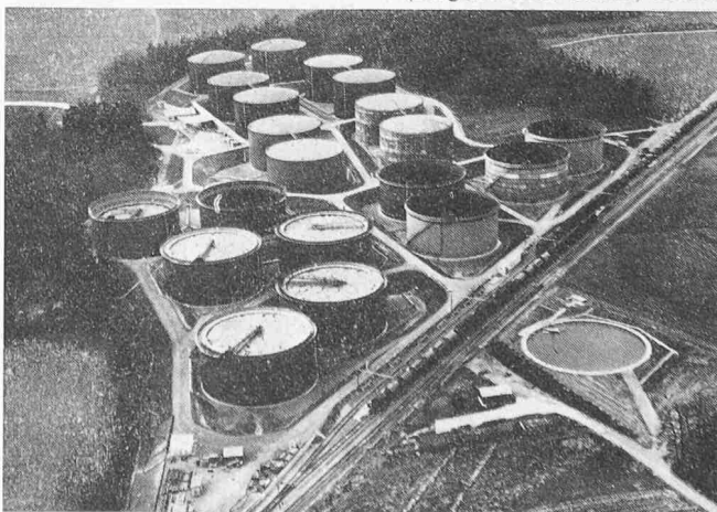
Gesamtansicht der Grosstankanlage der Carbura in Altishausen (Flugaufnahme Comet, Zürich)
